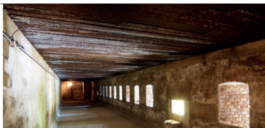
Forte Gazzera. Interno della caponiera del fronte di gola. A.C.D.A.M.F.M.
