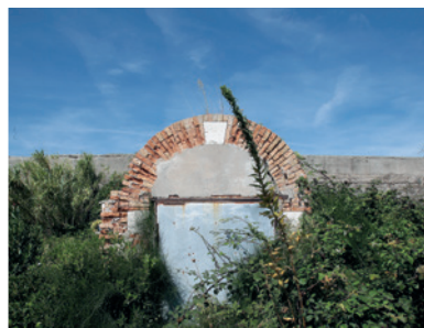
Batteria Manin. Postazione. A.C.D.A.M.F.M.
