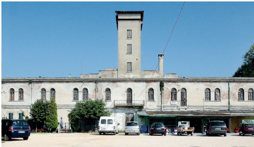
Caserma e torre telemetrica Cà Pasquali. A.C.D.A.M.F.M.
