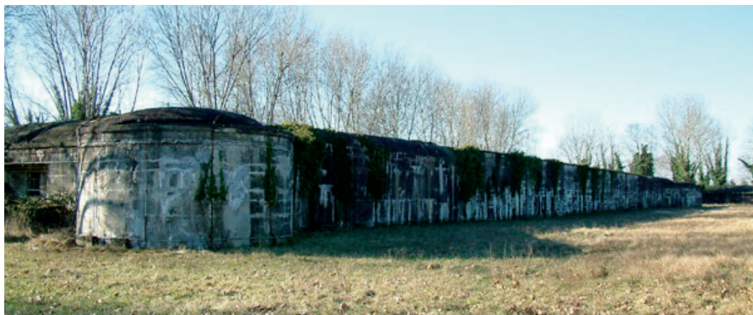
Forte Mezzacapo. Fronte d'attacco. A.C.D.A.M.F.M.
