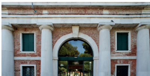
Forte San Pietro. Ingresso del ridotto. A.C.D.A.M.F.M.
