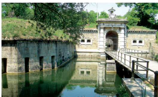
Forte Carpenedo. Portale d'ingresso. A.C.D.A.M.F.M.
