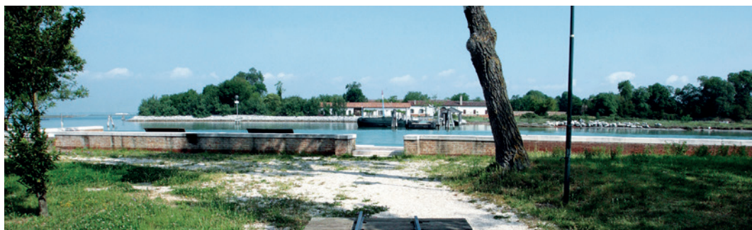
Binari del vecchio ponte tra l'isola di Sant'Erasmo e il Lazzaretto nuovo. A.C.D.A.M.F.M.
