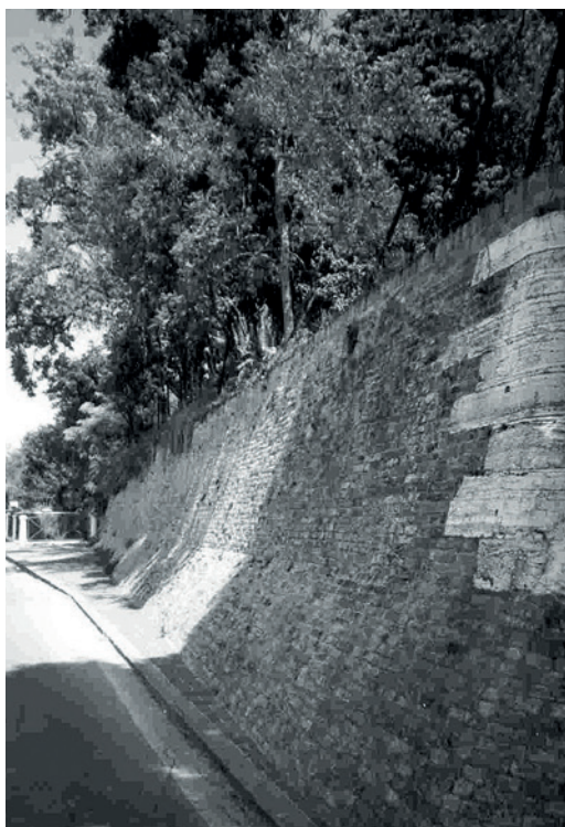
Forte San Nicolò del Lido. Tratto di bastione sud occidentale. A.C.D.A.M.F.M.
