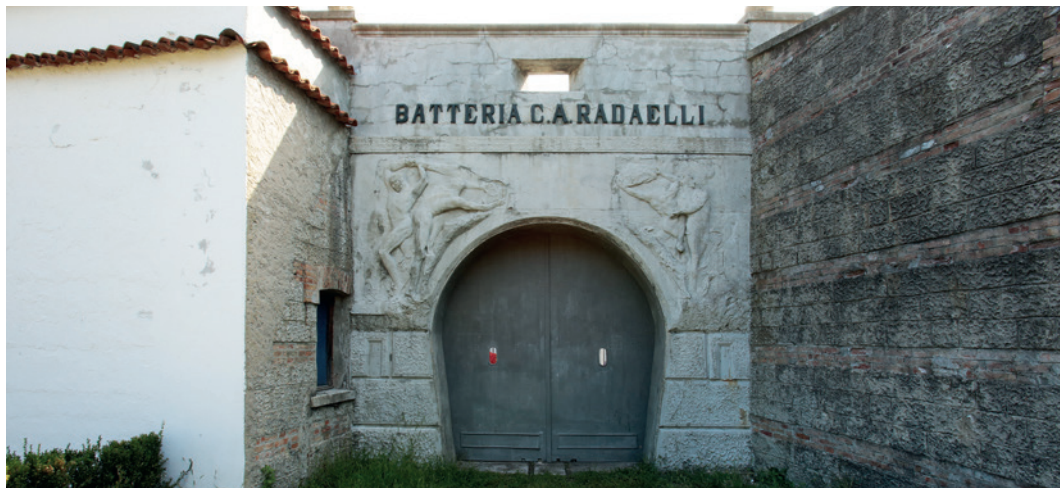
Batteria Radaelli. Ingresso. A.C.D.A.M.F.M.
