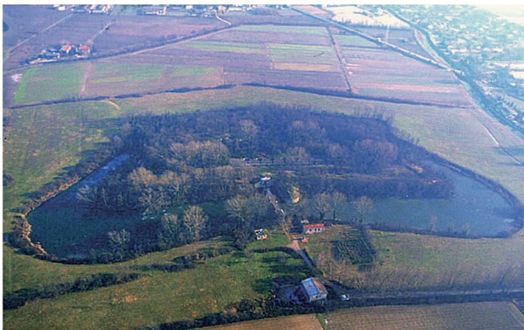
Forte Tron. Veduta aerea. A.C.D.A.M.F.M.
