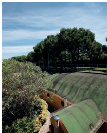
Batteria Morosini. A.C.D.A.M.F.M.
